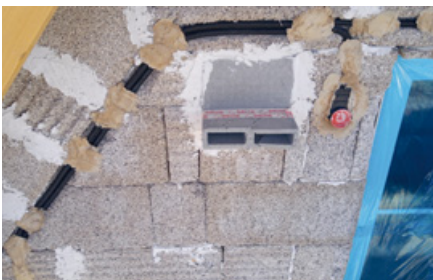
In den relativ weichen Steinen sind Elektroleitungen und Schalter schnell verlegt. Problematisch waren ihre Gewichtszunahme und Quellen durch Regen sowie Schwinden nach dem Vermauern. Bild: Martin Meyer
