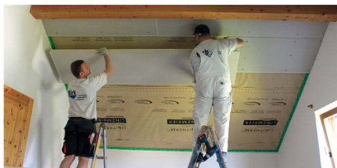
LINITHERM PAL GK-Dämmelement mit aufkaschierter Gipskartonplatte.
