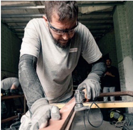
Statt vollständiger Rekonstruktion konzentriert wurden die vorhandenen Rahmen ertüchtigt und das Glas ausgetauscht.
