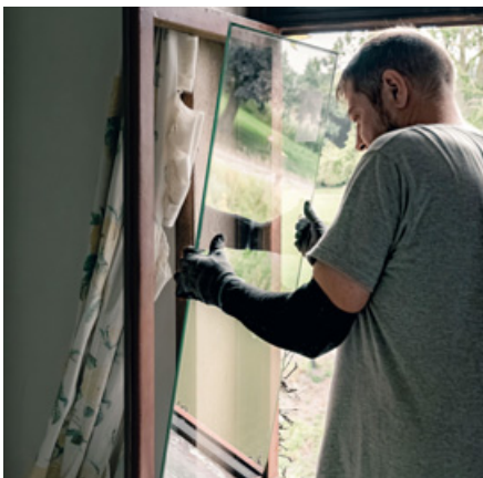
Trotz einer Gesamtglasdicke von lediglich 6,7 bis 20,1 Millimetern werden Wärmedämmwerte auf dem Niveau einer Dreifachverglasung erreicht. Der Wärmedurchgangskoeffizient (Ug-Wert) liegt bei 0,7 W/(m² K).
