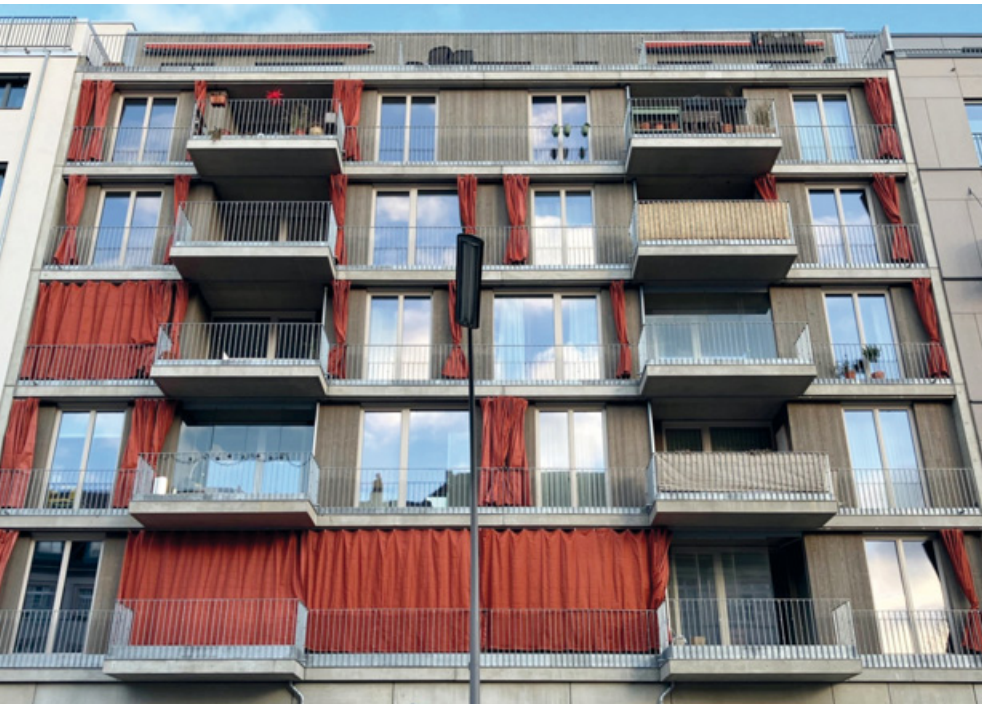
Sonnen- und Hitzeschutz durch Fassadentextilien: Bei diesem mehrgeschossigen Holz-Beton-Hybridgebäude wird sommerlicher Hitzeschutz durch Vorhänge erzielt, die außen vor den raumhohen Balkontüren und Fensterflächen platziert sind. Foto: Achim Dathe für den DHV
