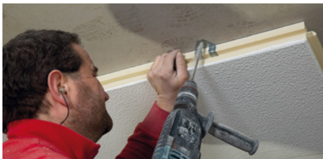
LINITHERM PAL KD BioZell und KD N+F – mechanische Befestigung mit Befestigungsklammern.
