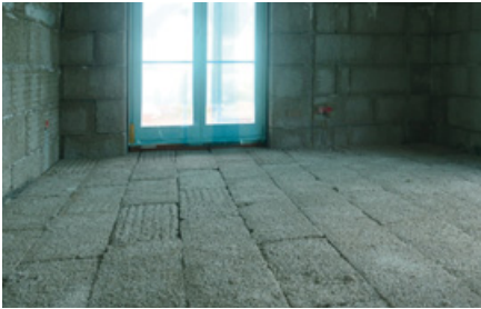
Insgesamt fast 7 Tonnen CO 2 speichern die Hanfkalk-Steine in nicht tragenden Außen- und Innenwänden sowie Dämmung der Böden. Bild: Roger Dauer
