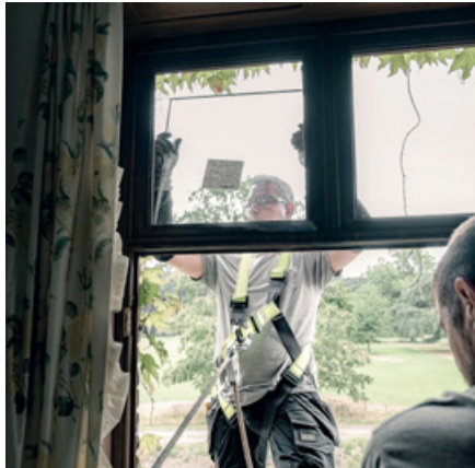
Viele Fenster waren aufgrund des umlaufenden Wassergrabens schwer zugänglich, daher wurde ein sogenanntes Eichhörnchengestütz eingesetzt.
