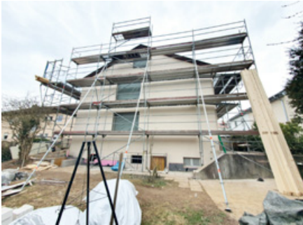
Das noch ungedämmte Gebäude mit bereits demontierten Fenstern.
