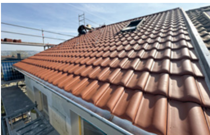
Das neu gedeckte Dach vor der Installation der Photovoltaikanlage.
