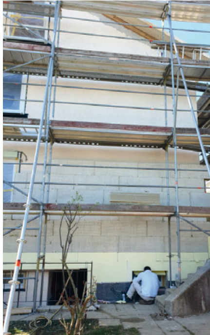
Die teilweise gedämmte Außenfassade.
