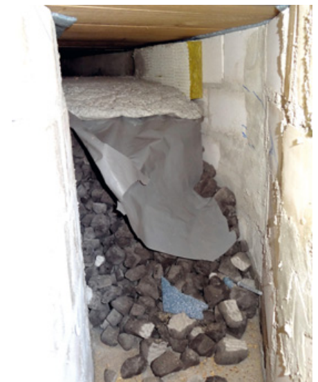
Luftkollektoren im Solarturm sammeln warme Luft, die eine Hypokauste unter dem Bühnenboden heizt – träge, aber lang anhaltend.
