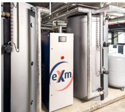
... und der Exergiemaschine, welche die hohen Temperaturen für die Warmwasserbereitung herstellt.
