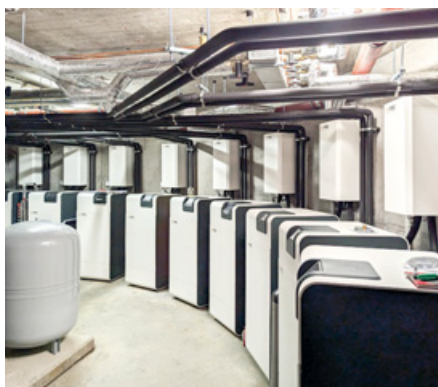
Der Heizungsraum des größten der neun Gebäude mit den Heizungswärmepumpen ...
