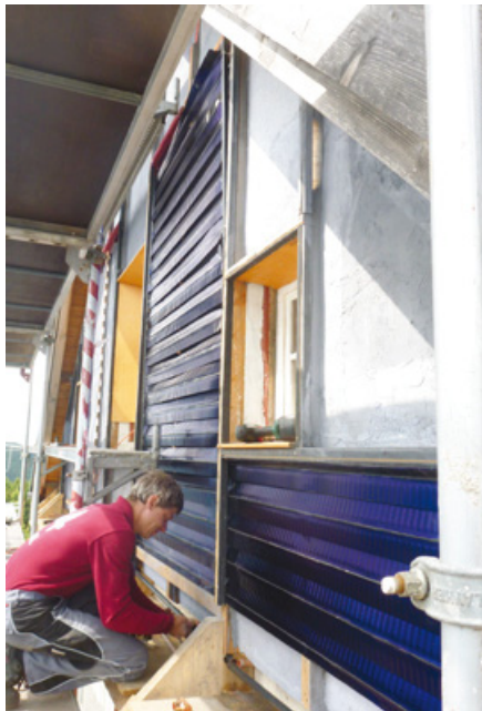
Auf die verputzte Schilfdämmung wurde direkt der Absorber des Hybridkollektors montiert. Foto: Rolf Canters
