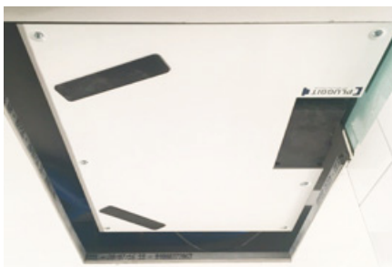
Die geringe Aufbauhöhe (170 mm) des Lüftungsgerätes PP-G erlaubt den verdeckten Einbau in der Zwischendecke der Bäder und die einfache Wartung durch die Revisionsöffnung.
