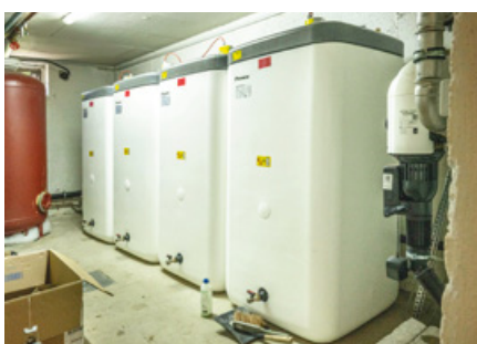
Im Keller des Mehrfamilienhauses wurden vier Daikin ST-Speicher installiert, welche die 24 Wohnungen zuverlässig mit frischem, sauberem und hygienisch einwandfreiem Wasser versorgen. Foto: © DAIKIN
