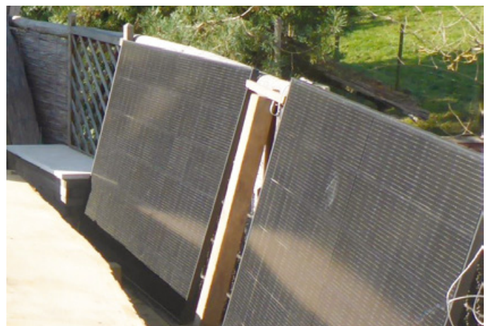
Bifaciale PV-Module werden auch als Geländer einer großen Terrasse eingesetzt. Foto: Achim Pilz
