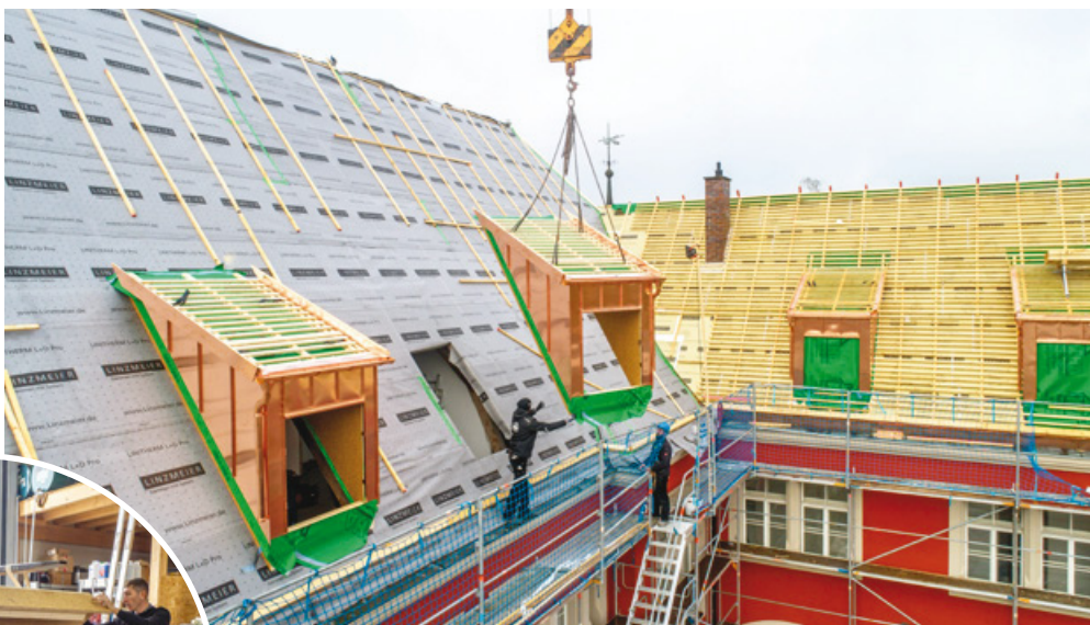
Vorkonfektionierte Litec Gaubensysteme kamen zum Einsatz.
