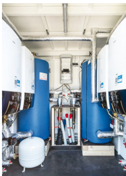
Im Keller des Mehrfamilienhauses wurden vier Daikin ST-Speicher installiert, welche die 24 Wohnungen zuverlässig mit frischem, sauberem und hygienisch einwandfreiem Wasser versorgen. Foto: © DAIKIN
