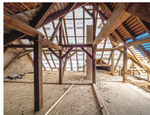
Leichte PU-Dämmung ermöglichte den Erhalt des originalen Dachstuhls.
