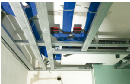
Lüftungsgerät und die Lüftungsleitungen sind so kompakt, dass sie ohne Probleme in die abgehängten Decken mit einer Revisionsöffnung integriert werden können.
