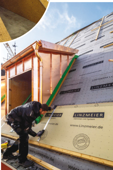
Vorkonfektionierte Litec Gaubensysteme kamen zum Einsatz.
