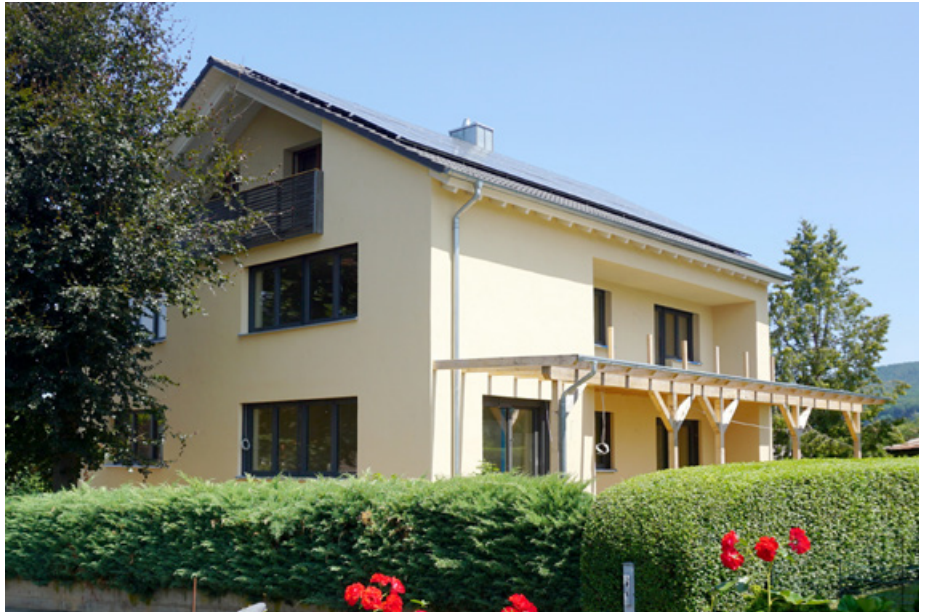
Abschließend erhält das diffusionsfähige WDVS eine pigmentierte Dispersionssilikatfarbe, welche die Makroporen verschließt.
