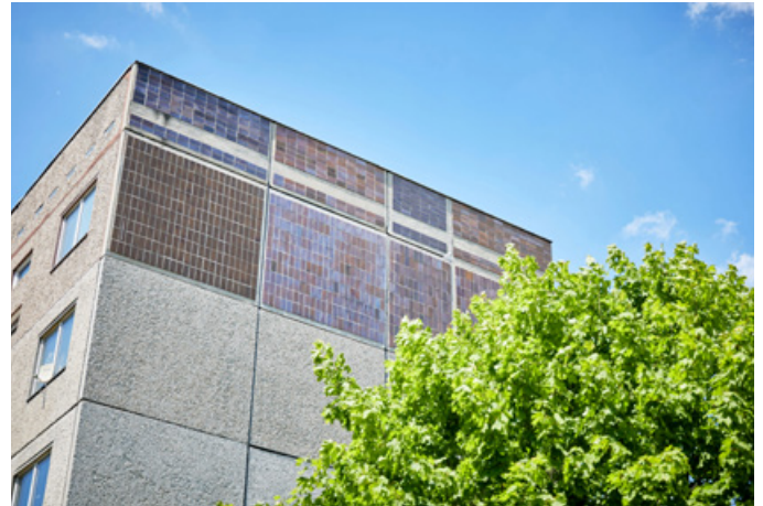
Der Altuntergrund bestand zu großen Teilen aus großformatigen Betontafeln mit Waschputz. Am oberen Gebäudeabschluss waren einige Flächen mit Keramik verkleidet.
