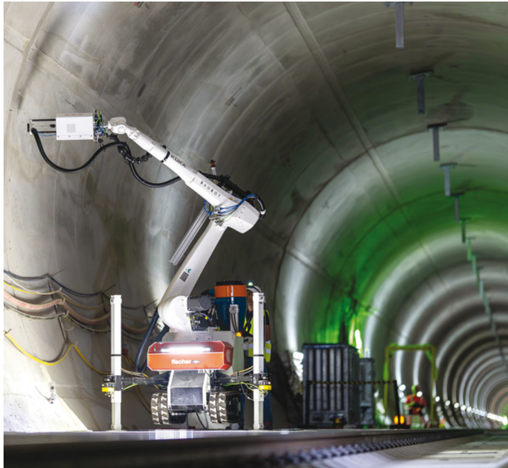
Fischer bringt Expertise in den Bereichen KI, Robotik und Digitalisierung im Bauwesen ein: Im Bild der Fischer Bauroboter BauBot. Foto: fischer
