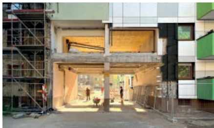
Dank sehr gut erhaltener Bausubstanz wurde nur erneuert, was erneuert werden musste, z. B. die Fassade mit einer VHF aus zeitgemäßer Dämmung und Cradle-to-Cradle zertifizierten Equitone-Fassadentafeln. Foto: Druschke Architektur
