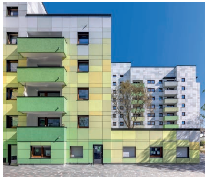
Modernisierung statt Abriss: Die erneuerte Fassade aus EQUITONE [natura] PRO Faserzementtafeln akzentuiert die Gebäude des Citywohnpark Duisburg farblich von Hellgrau über Gelb bis Grün.
