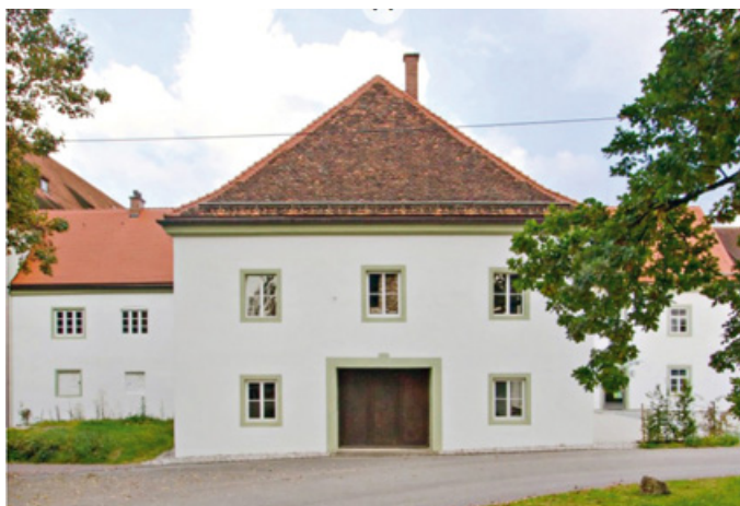
Die Forscher untersuchen das Zusammenwirken von Wandheizungen und Innendämmungen im Denkmalbestand, wie in den sechs Räumen der Alten Schäferei des Klosters Benediktbeuern.
