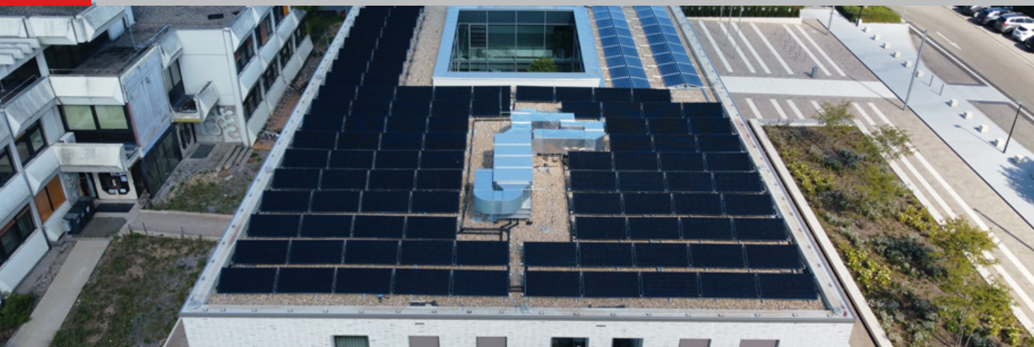
Das Dach des Rathaus- und Verwaltungsgebäudes der Verbandsgemeinde Offenbach an der Queich ist optimal mit Solartechnik belegt: im vorderen Bereich PVT (dunkel) im hinteren Bereich PV (hell). Foto: Consolar Solar Energiesysteme
