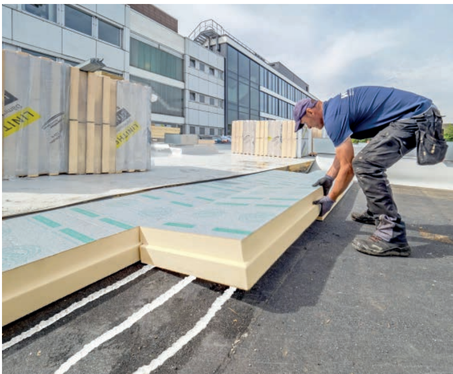
Auf Dach 1 wurde eine ebene, 160 Millimeter dicke PU-Dämmung verlegt.
