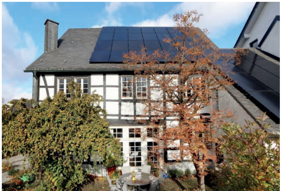
Das nach Süden ausgerichtete Dach sowie der Anbau tragen die PV-Anlage.
