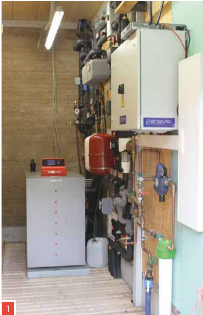
Bild 1: Die Heizzentrale des Naturinfozentrums (NIZ) mit Sole-Wasser-Wärmepumpe. Bild 2&3: Die 30 Meter lange Lehmwand mit einem U-Wert von 1,5 speichert die Sonnenwärme. In einem Forschungsprojekt werden Oberflächentemperaturen und Wärmedurchgänge gemessen.
