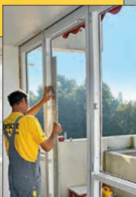
Einpassen der neuen Elemente und saubere Anschlüsse zum Mauerwerk und zur Fensterbank.
