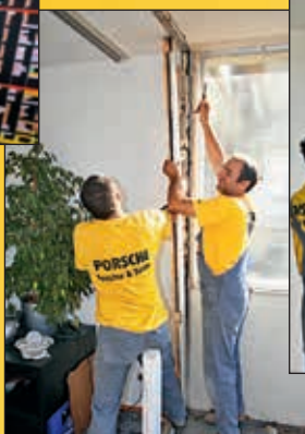
Sorgfältige Demontage, ohne das Mauerwerk zu beschädigen.
